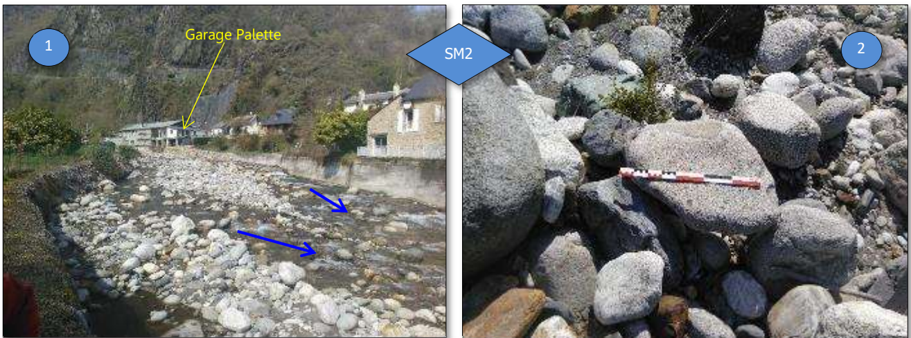
Figure 5 : Singularité morphologique SM2, (1) → Vue vers l'amont on note l'élargissement important et l'aggradation du lit cherchant à réajuster sa géométrie ; (2) → Granulométrie grossière de cette structure alluvionnaire (cf. échelle de 50 cm)
