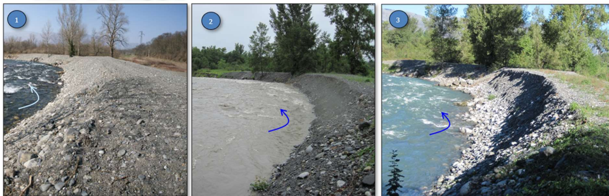
Figure 38 : Exemple de rephotographie (gave de Pau), la même vue (prise du même endroit) permettant ainsi le suivi d'un transfert-réinjection de matériaux. On voit au fil des saisons (et des crues) les matériaux déposés en glaciais de berge s'éroder petit à petit (injection-retard) et se disséminer dans le gave de Pau.
