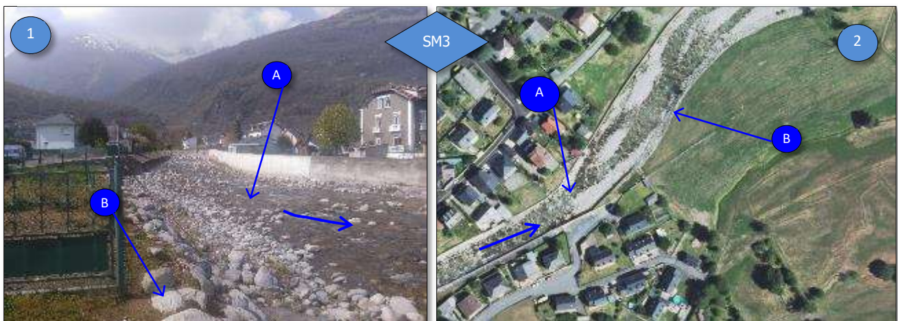
Figure 7 : (1) → zone de l'apex fixé du cône résiduel (début d'ouverture de la section et début du masque rocheux) ; (2) → zone de l'apex (A), on note le désaxement du lit et le masque rocheux (B) en rive droite ainsi que le mur-digue en rive gauche. Le lit commence à divaguer voire tresser.
