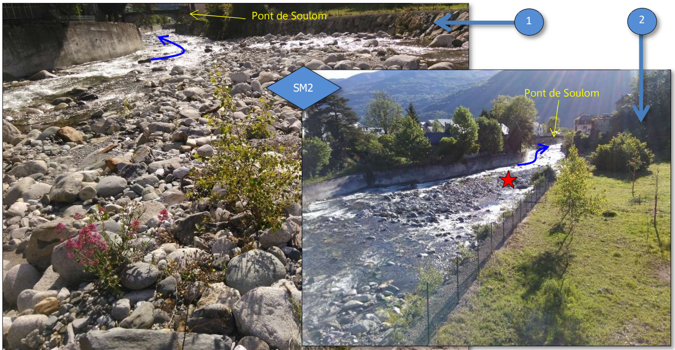
Figure 4 : Vue de la partie aval de la singularité SM2 (1) → Vue depuis l'étoile sur la photographie n° 2 on l'on voit les désaxements du lit et son rétrécissement, lequel génère l'atterrissement ; (2) → vue plus large et en hauteur de la zone montrant désaxement et rétrécissement de la section d'écoulement fortement contrainte
