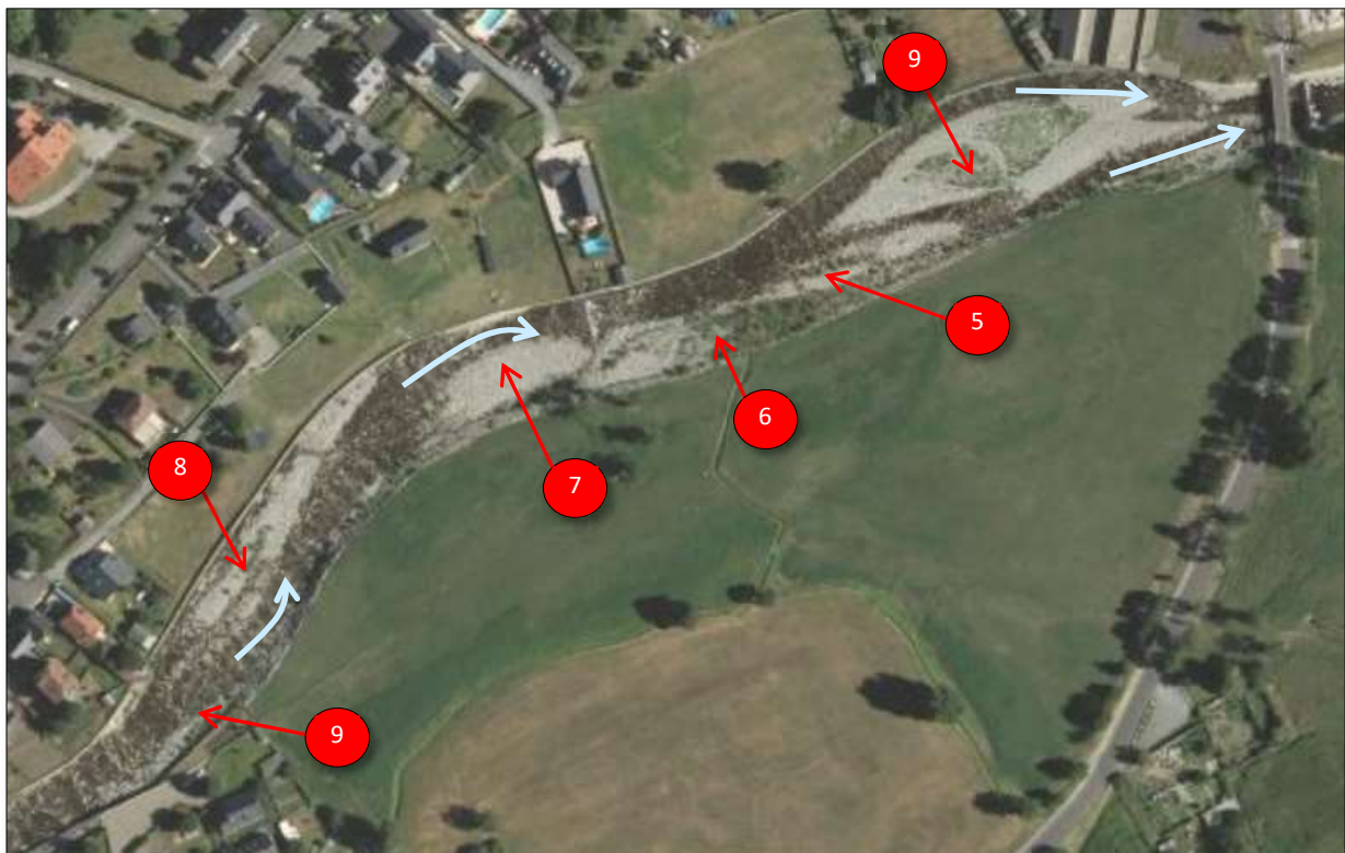
Figure 30 : détail des atterrissements de la singularité SM3
