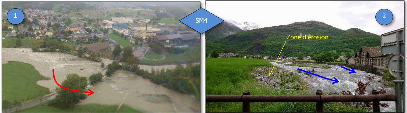
Figure 11 : Pont interzones, (1) lors de la crue de 2012, montrant les débordements et la zone d'érosion et de dépôt ; (2) En 2019, vue des stigmates des crues protégées par un masque rocheux
