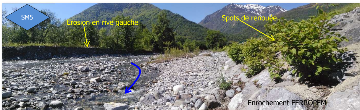
Figure 14 : Vue de la partie élargie en aval du pont interzones. Le lit est corseté en rive gauche et les berges sont érodées en rive droite. Les accrétions sont importantes.
